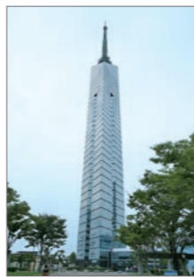
全長234メートルと海浜タワーとしては日本一の高さを誇る「福岡タワー」
